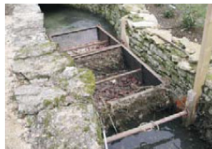
Filtre mobile installé sur un cours d'eau
